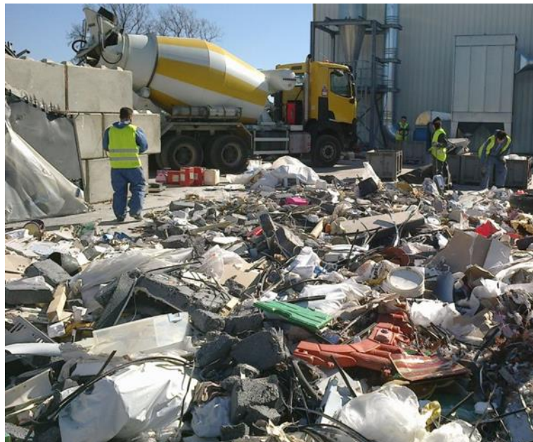
Figure 14. Tri des éléments > 400 mm sur les bennes de déchèterie.
